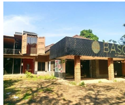
Gambar 5.3 Tanah dan Bangunan SET
